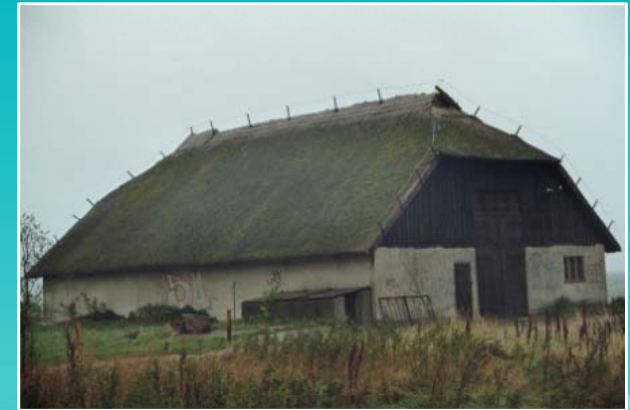
5) 1937 „Tangscheune“ auf der Insel Rügen zur Seegraströcknung erbaut
